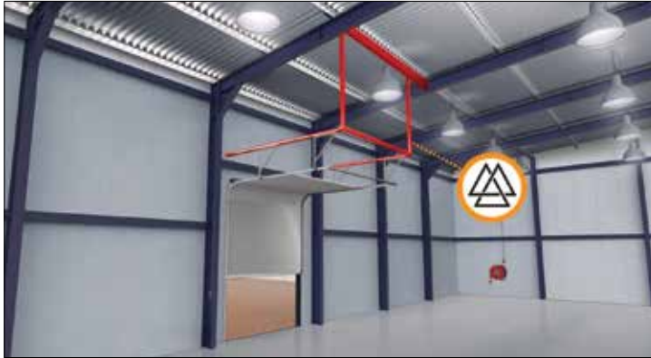
Stahlrahmen, an der Decke montiert
