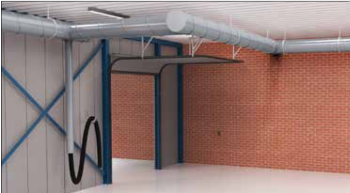
Behinderung des freien Luftauslasses
